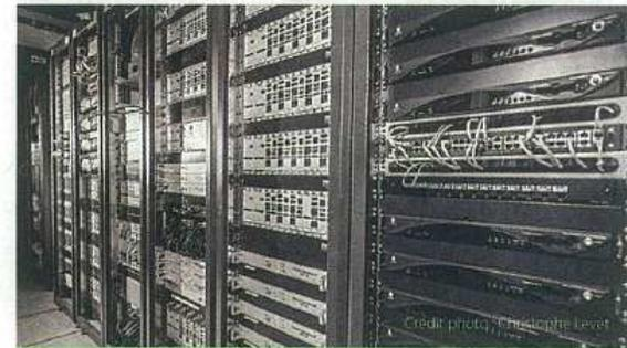
Tête de réseau Numericable : point de départ de la Fibre Optique
